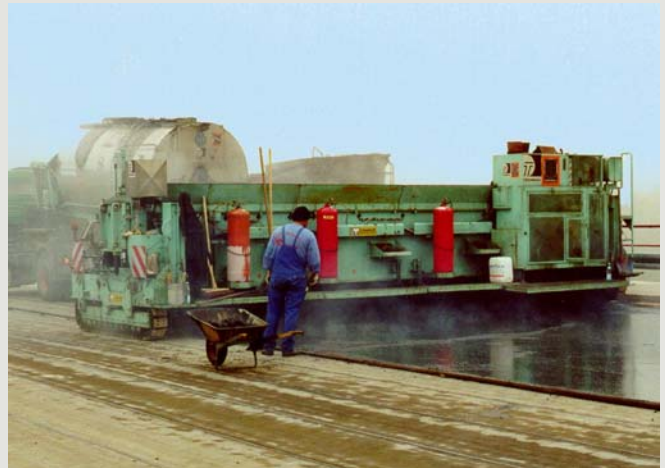
Einbau von temperaturabgesenktem Gussasphalt
