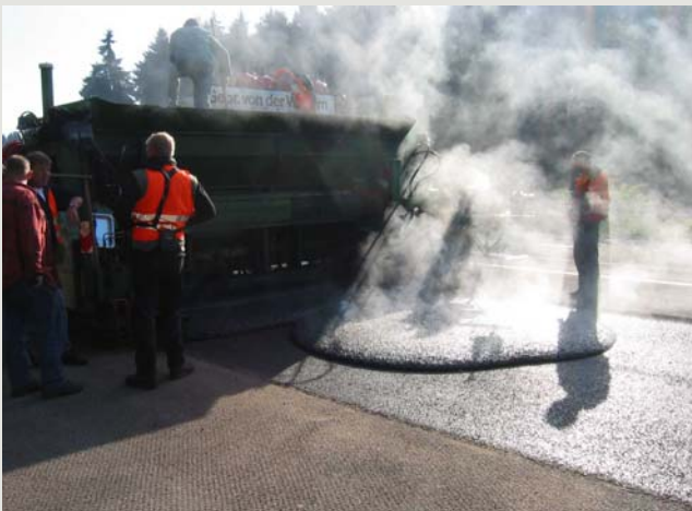
Einbau von Gussasphalt bei Temperaturen \geq 250^{\circ}\text{C}
